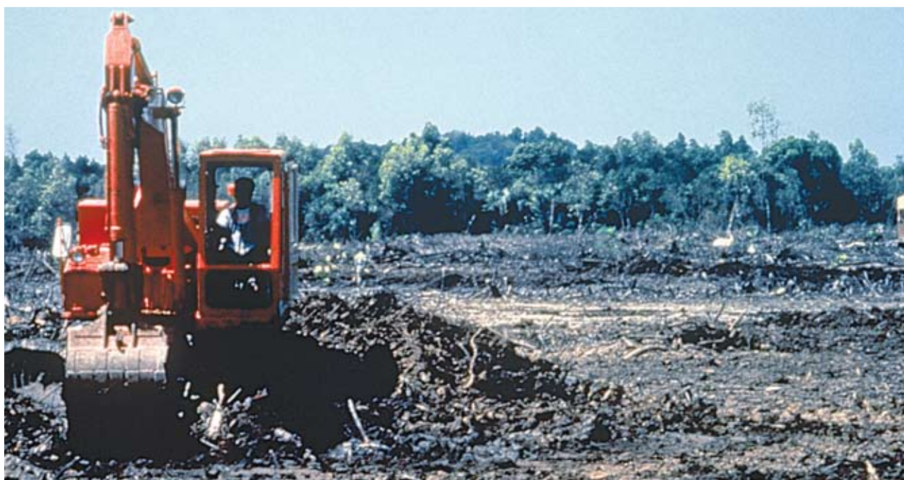
Grävning av räkodlingsdamm, Malaysia.
